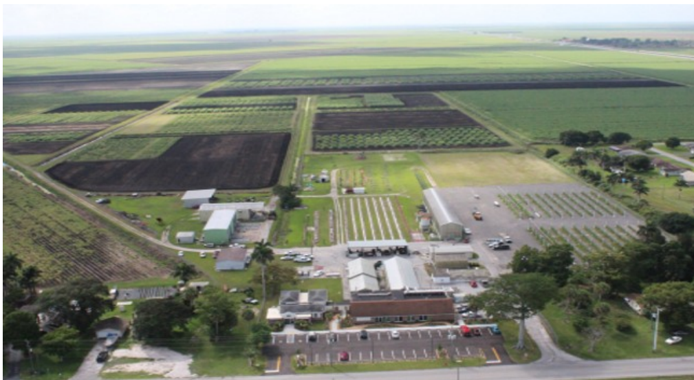
真实现场照片 · P04 Canal Point站区鸟瞰
